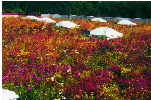
Abb. 147 Solar-Fabrik, Freiburg; Dach- begrünung auf der Produktionshalle
